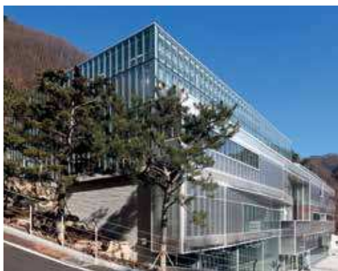
■ Fachada y cubierta de techo, Danpalon® 12, 900 mm, cristal, Danpalon® 10, 600 mm, ice, 3.500 m²
