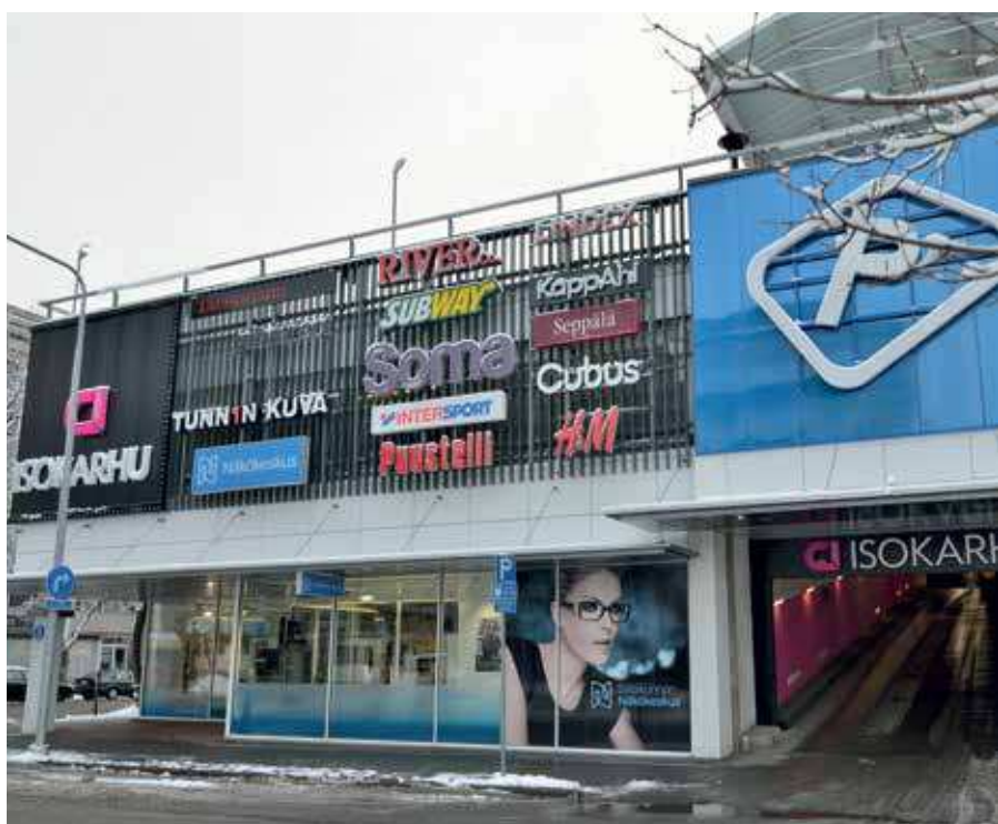
■ Revestimiento Superpuesto Ventilado Danpalon® RSV 12, 900 mm, colores negro con acabado Softlite, azul zafiro con opacificante negro Softlite, 220 m²
